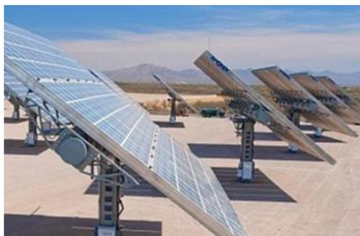
Рисунок 4 - Трекер с двумя осями вращения
